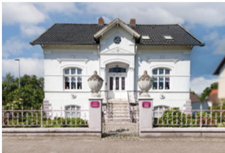
Oldersum: Elegante Villa aus der Gründerzeit – Großzügige Räume und stilvolle Ausstattung Denkmal - Energieausweis nicht notwendig. Baujahr: 1896 • Wohnfläche: ca. 215 m 2 Grundstücksfläche: ca. 1.000 m 2 E&V ID W-02W3ON
