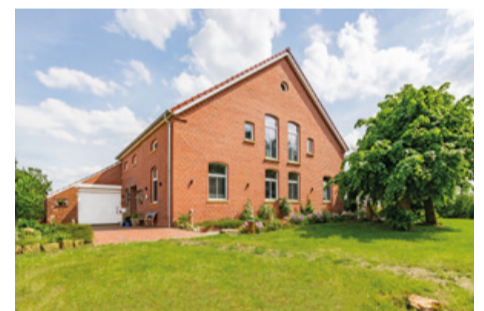
Emden: Energetisch sanierter Gulfhof Bedarfsausweis: Endenergiebedarf kWh/(m 2 *a): 31, Energieklasse: A, Baujahr: 1929 Wohnfläche: ca. 233 m 2 Grundstücksfläche: ca. 3.920 m 2 E&V ID W-02VUPH
